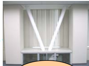
耐震補強工事
