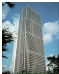
新宿センタービル ★★★★
