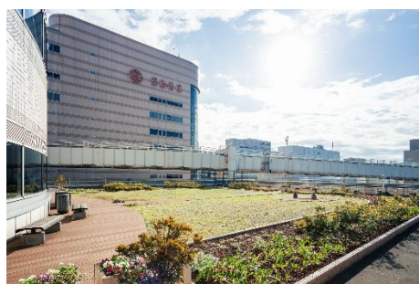
屋上緑化（センシティブビルディング）
