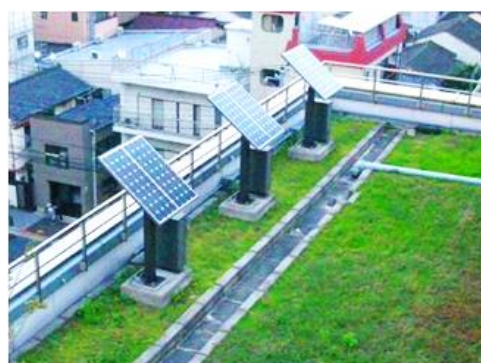
オリナスタワー（太陽光パネル）
