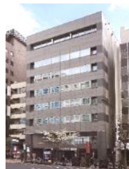
JPR 市ヶ谷ビル
