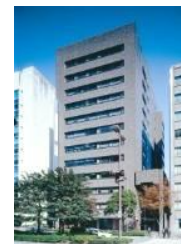
JPR 博多ビル
