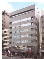
JPR 市ヶ谷ビル
