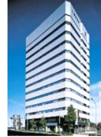
事B-5 新横浜第二センタービル
