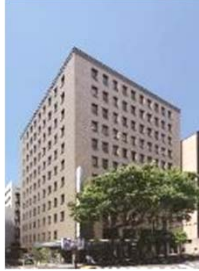
事B-3 JPR横浜日本大通ビル
