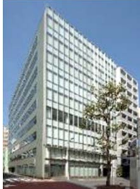
事A-20 JPR日本橋堀留ビル
