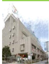
商B-4 JPR武蔵小杉ビル
