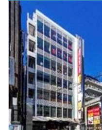
商A-7 FUNDES水道橋
