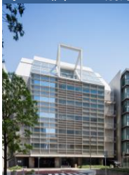
事A-2 兼松ビル別館
