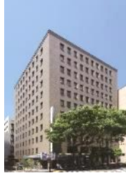
事B-3 JPR横浜日本大通ビル
