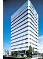
事B-5 新横浜第二センタービル
