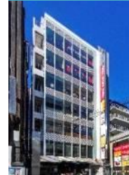
商A-7 FUNDES水道橋
