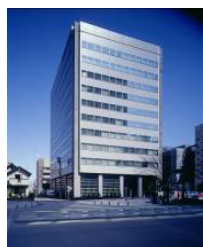
事C-12 損保ジャパン仙台ビル
