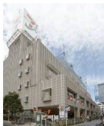
商B-4 JPR武蔵小杉ビル
