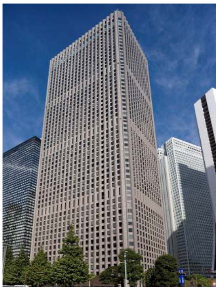
事A-14 新宿センタービル
