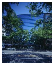
事C-18 JPR博多中央ビル
