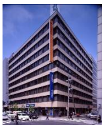
事C-4 東京建物本町ビル
