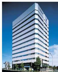
事B-5 新横浜第二センタービル
