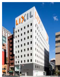
事A-19 東京建物京橋ビル
