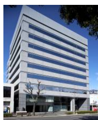
事C-19 JPR名古屋伏見ビル
