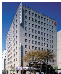
事B-3 JPR横浜日本大通ビル
