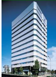
事B-5 新横浜第二センタービル
