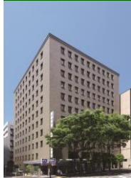
事B-3 JPR横浜日本大通ビル
