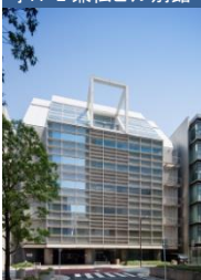
事A-2 兼松ビル別館
