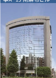
事A-15 南麻布ビル
