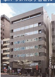
事A-9 JPR市ヶ谷ビル
