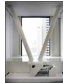
新設した制震ダンパー
