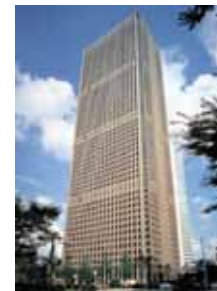
新宿センタービル
