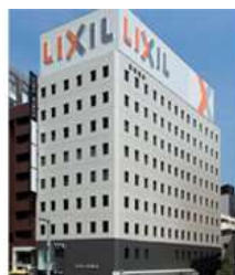
東京建物京橋ビル
