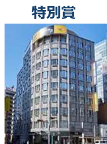
JPR 堂島ビル
