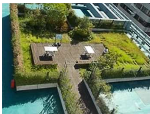
屋上緑化（東京建物本町ビル）
