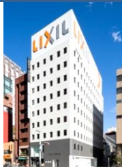
事A-19 東京建物京橋ビル
