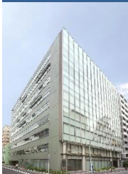
事A-20 JPR日本橋堀留ビル
