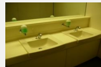
新宿センタービル・トイレ改修
