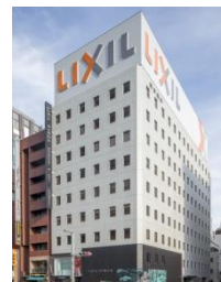
事A-19 東京建物京橋ビル
