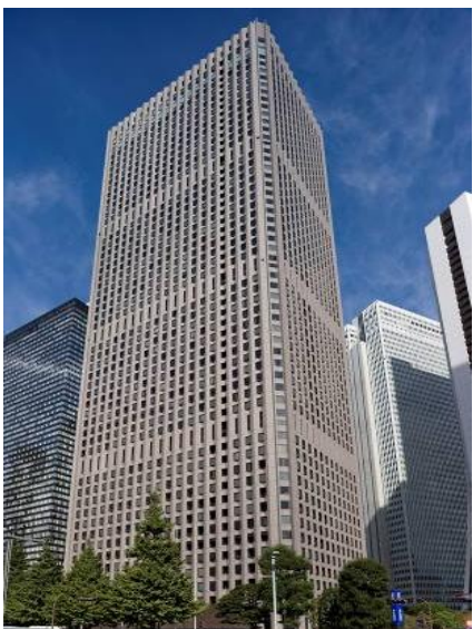
事A-14 新宿センタービル
