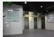
新麹町ビル・エントランス改修
