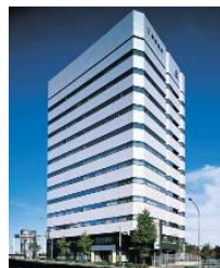
事B-5 新横浜第二センタービル
