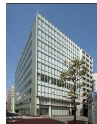
事A-20 JPR日本橋堀留ビル
