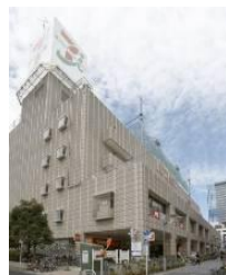
商B-4 JPR武蔵小杉ビル
