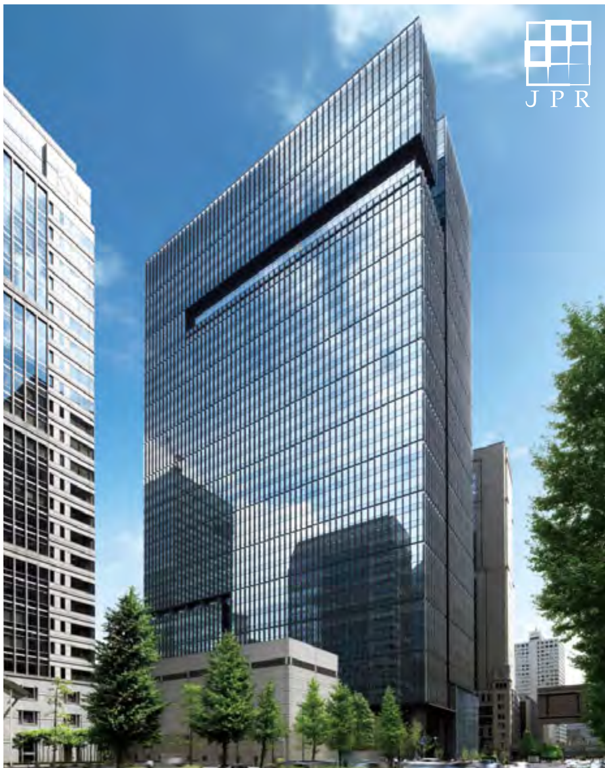
大手町タワー(底地)
