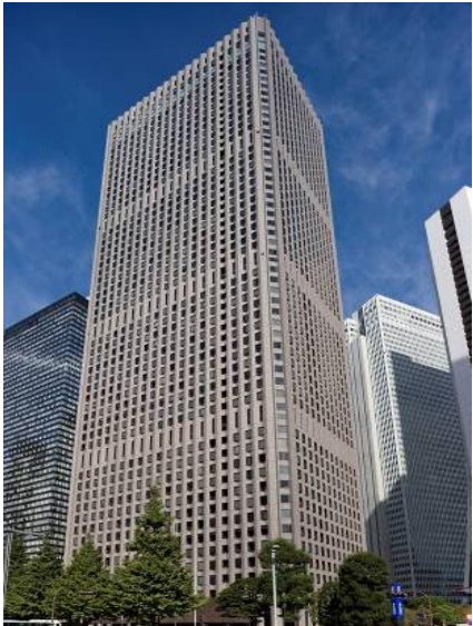
事A-14 新宿センタービル
