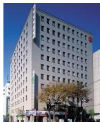
事B-3 JPR横浜日本大通ビル
