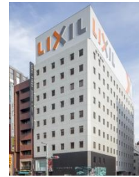
事A-19 東京建物京橋ビル
