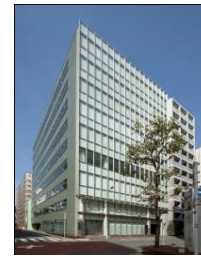
事A-20 JPR日本橋堀留ビル
