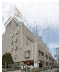
商B-4 JPR武蔵小杉ビル
