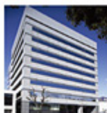
事C-19 JPR名古屋 伏見ビル
