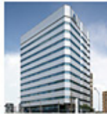
事B-5 新横浜第二 センタービル
