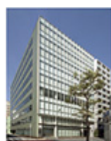
建A-20 JPR日本橋総館ビル
