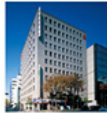
事B-3 JPR横浜 日本大通ビル
