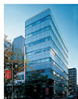
建A-3 JPR人形町ビル
