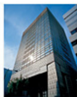
建A-1 業松ビル
