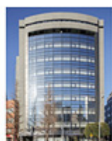
建A-15 南麻布ビル
