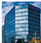
事C-1 新高城南 センタービル
