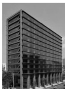
薬院ビジネスガーデン (福岡県福岡市)
