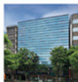
事C-18 JPR博多 中央ビル
