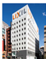
建A-19 東京建物京橋ビル
