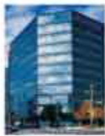
東東16 新浜町南 センタービル
