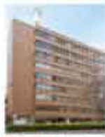
東東10 東京建物横浜ビル
