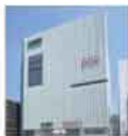
高A-27 新橋三丁目ファーストビル
