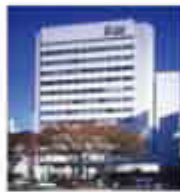
高A-12 ビックス新橋ビル
