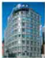
東東17 JPR広島ビル
