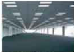
・約400坪の整形無柱空間
