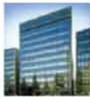
高A-8 福岡ビル
