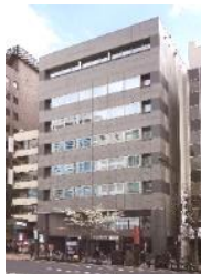
JPR Ichigaya Bldg.
