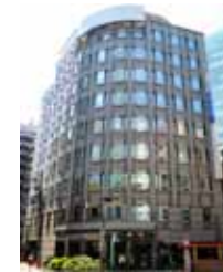
C-17 JPR Dojima Bldg.
