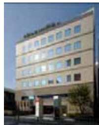
A-17 Rokubancho Building
