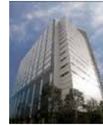
B-9 Rise Arena Bldg.
