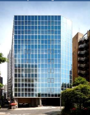
A-27 JPR Kojimachi Bldg.
