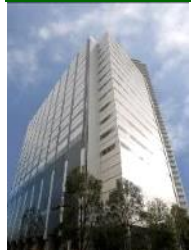
B-9 Rise Arena Bldg.
