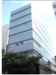
A-3 JPR Ningyo-cho Bldg.
