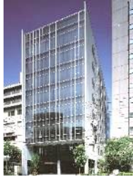
A-16 Shinagawa Canal Bldg.
