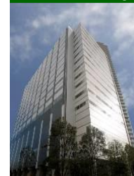
B-9 Rise Arena Bldg.
