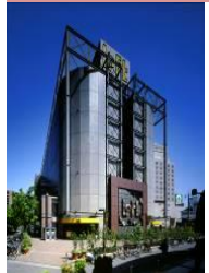
C-1 JPR Umeda Loft Bldg.
