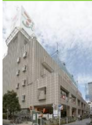
B-4 JPR Musashikosugi Bldg.
