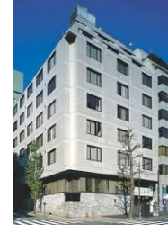
A-4 Shin-Kojimachi Bldg.
