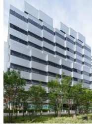
A-25 Shibadaimon Center Bldg.
