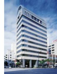
C-9 JPR Naha Bldg.
