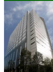
B-9 Rise Arena Bldg.
