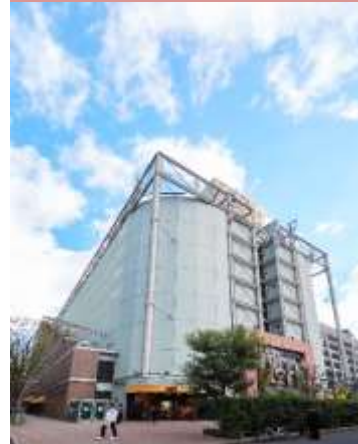
C-1 JPR Umeda Loft Bldg.
