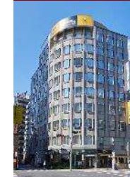
C-17 JPR Dojima Bldg.
