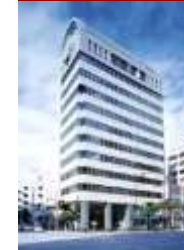
C-9 JPR Naha Bldg.
