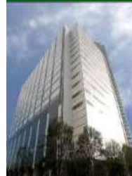
B-9 Rise Arena Bldg.
