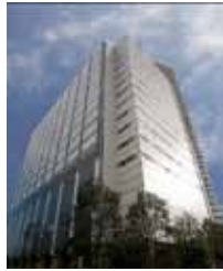
B-9 Rise Arena Bldg.
