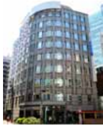
C-17 JPR Dojima Bldg.
