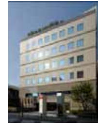
A-17 Rokubancho Building
