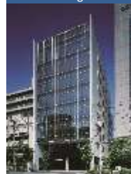
A-16 Shinagawa Canal Bldg.
