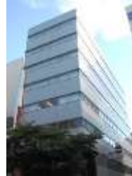
A-3 JPR Ningyo-cho Bldg.
