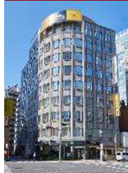
C-17 JPR Dojima Bldg.
