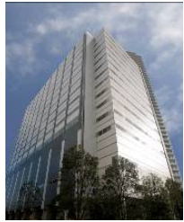
B-9 Rise Arena Bldg.
