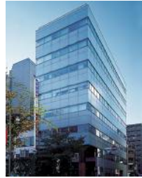
A-3 JPR Ningyo-cho Bldg.
