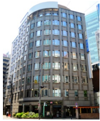
C-17 JPR Dojima Bldg.
