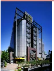
C-1 JPR Umeda Loft Bldg.
