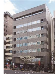
A-9 JPR Ichigaya Bldg.
