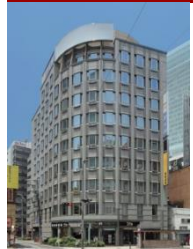
C-17 JPR Dojima Bldg.
