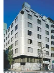
A-4 Shin-Kojimachi Bldg.
