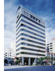
C-9 JPR Naha Bldg.
