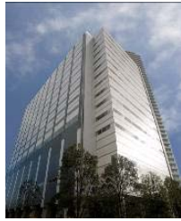
B-9 Rise Arena Bldg.
