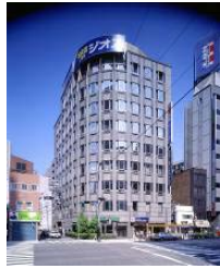
C-17 JPR Dojima Bldg.
