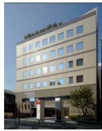
A-17 Rokubancho Building
